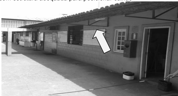
Figura 3: Telhado com estrutura adequada para posicionar calhas
