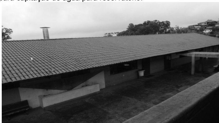
Figura 2: Telhado para captação de água para reservatório.
